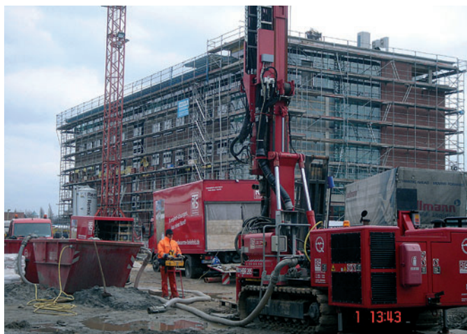
Bild 1. Logistikzentrum Hellmann in Osnabrück, durchführendes Unternehmen: RTS GmbH, Bielefeld
