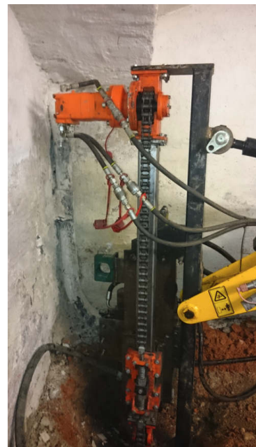
Abb.2: Bohrarbeiten mit der Leichtbaulafette bei einer Raumhöhe von 1,50 m
