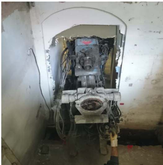
Abb. 1: Einsatz des Kellerbohrgerätes „Hütte 202“ unter beengten Verhältnissen
